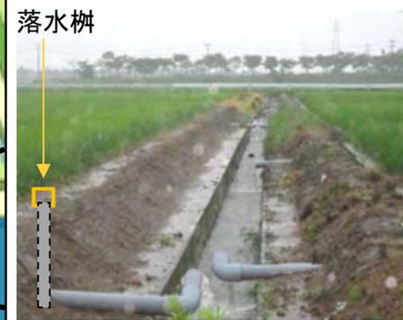
排水路への雨水の流出を抑制
