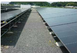
敷均し材として活用
